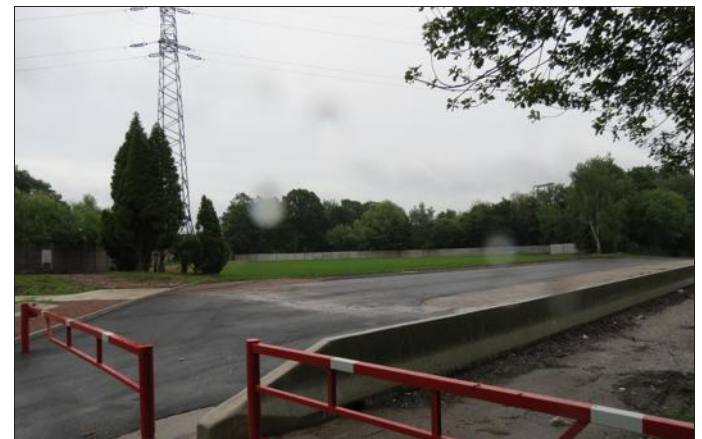
Les travaux de l'aire d'accueil, provisoire, aménagée au puits Simon, sont terminés, mais l'accès est encore interdit car les terrains sont gorgés d'eau. Photo RL
