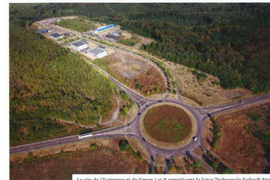
Le site de l'Eurozone et de Simon I et II constitue le futur Technopôle Forbach Nord.
