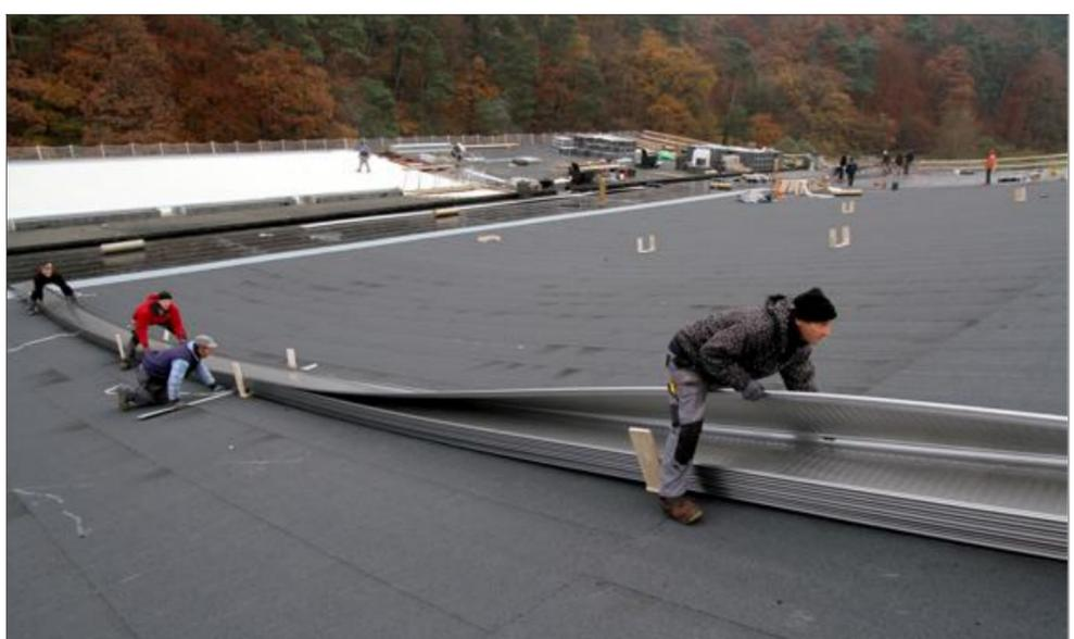
Les plaques d'aluminium de 33 mètres 80 sont fabriquées sur place avec une machine venue spécialement d'Italie. Elles sont montées et stockées sur le toit. Les couvreurs commenceront à les poser la semaine prochaine. Photo Philippe RIEDINGER.
